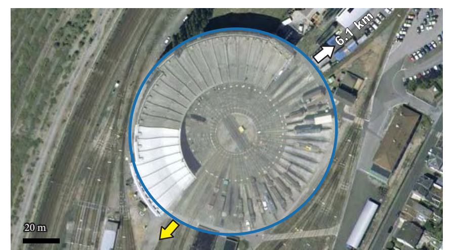
33. Rotonde ferroviaire, 20e siècle
